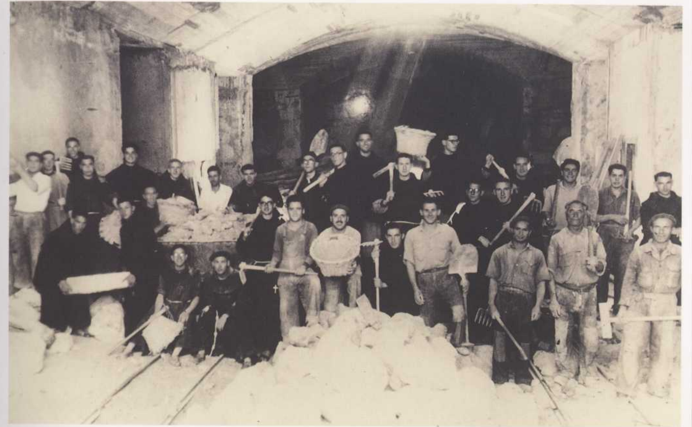
Obreros y frailes en los trabajos de la nueva iglesia.
