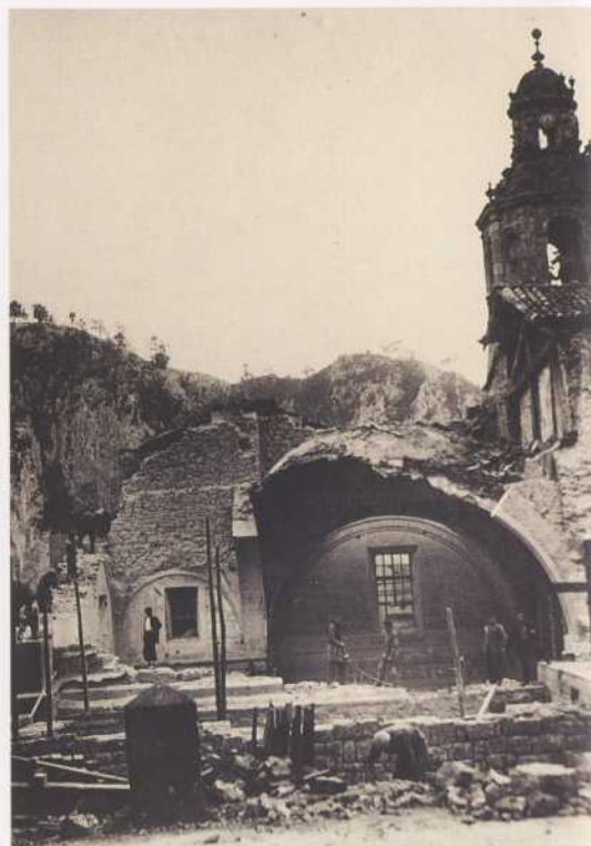
La Iglesia vieja antes de su total demolición.
