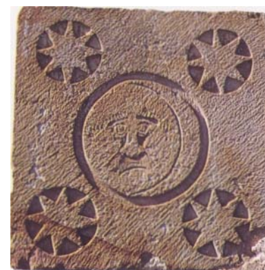
Placa de piedra en la fachada de la casa-torre.
