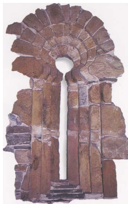
Ventana del ábside, de arco de herradura.
